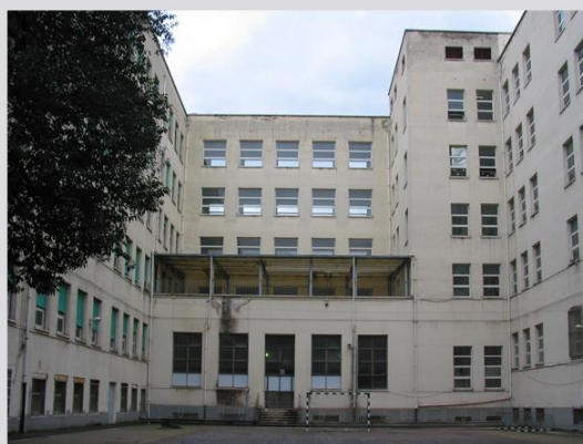
Scuola in via Boccioni - facciata del corridoio
