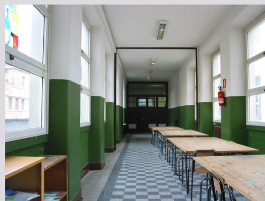
Scuola in via Boccioni - corridoio, interno
