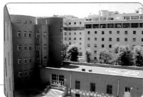
6 - CORTE INTERNA DELLA SCUOLA MATERNA ED ELEMENTARE "G. FRANCESCHI"
