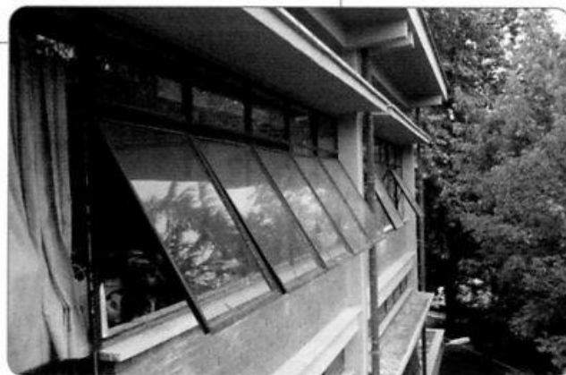
9 - PARTICOLARE DELLA FACCIATA DELLA SCUOLA MATERNA ED ELEMENTARE "V. H. GIROLAMI" IN LARGO GIROLAMI (1960-62)
