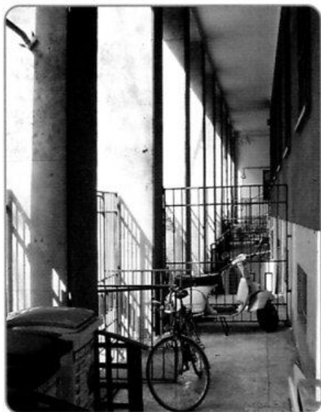
22 – SCUOLA MATERNA ED ELEMENTARE "G. FRANCESCHI". LA CHIUSURA CON UN CANCELLO E LA PARZIALE OSTRUZIONE DEL PORTICO DI ACCESSO SU VIA DONNA OLIMPIA NON PERMETTONO PIÙ LA PIENA FRUIBILITÀ DELLO SPAZIO.
