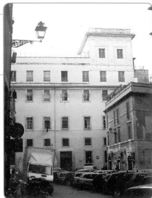
23 – SCUOLA MATERNA ED ELEMENTARE "TRENTO E TRIESTE". LA SOPRAELEVAZIONE DELL'EDIFICIO, EVIDENZIATA DALLA DIFFERENTE COLORITURA DELLA FACCIATA SULLA PIAZZA DEL MONTE DI PIETÀ, ROMPE LA CONTINUITÀ DI PROSPETTO E L'ARMONIA DEI VOLUMI.
