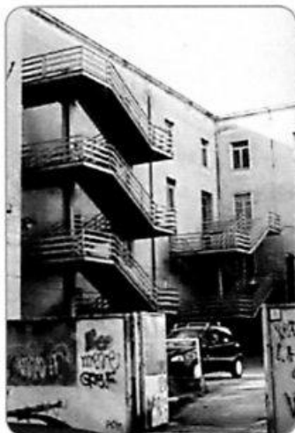
21 - SCUOLA MEDIA "A. MANZONI". LE SCALE ANTINCENDIO POSTE ALL'ESTERNO INGOMBRANO E DETURPANO I CORTILI DELL'EDIFICIO.
