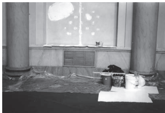
Fig. 11. Acquario Romano (Roma), 2004-06. Il progetto degli impianti di climatizzazione si adattava in vecchi passaggi impiantistici, integrandosi nelle strutture non originali degli anni Trenta e successive.
