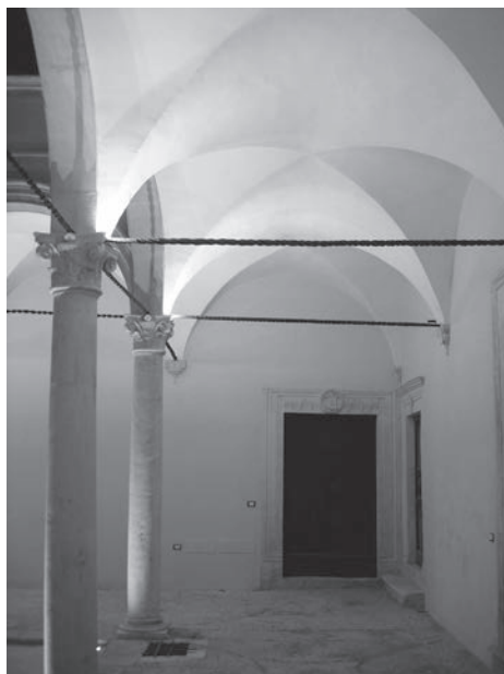
Fig. 7. Palazzo Carli-Benedetti (L'Aquila), 2012-16. Vista del cortile monumentale durante le prove notturne per la regolazione dell'illuminazione; il cablaggio a basso voltaggio dei moduli miniaturizzati per illuminazione indiretta avviene con coppie di cavi unipolari neri che si avvolgono ad elica intorno alle colonne tortili, risultando sostanzialmente invisibili sia di giorno che di notte.
