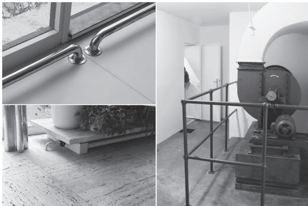
Fig. 6. Villa Tugendhat, Brno. In alto a sinistra: il flauto in acciaio cromato che funge da radiatore antiappannamento per le grandi vetrate. In basso a sinistra: dettaglio del sistema di riscaldamento posto al di sotto dell'elemento in travertino, sul quale poggiano i vasi delle piante. A destra: elemento per l'ottenimento della ventilazione forzata interna alla villa.
