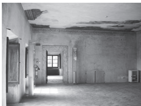
Fig. 2. Palazzo Chigi-Zondadari a S. Quirico d'Orcia (Siena), 2004-05. Vista di alcuni ambienti a lavori terminati, con gli affreschi restaurati e i nuovi totem multifunzionali montati.
