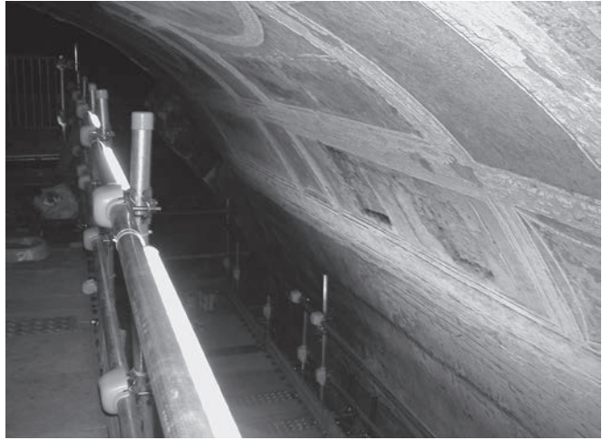
Fig. 5. L'impianto predisposto per il restauro e le visite guidate sulle impalcature della Sala della volta dorata alla Domus Aurea. Questa sperimentazione aprì le porte a un uso più esteso delle emissioni LED nei grandi ambienti ipogei.
