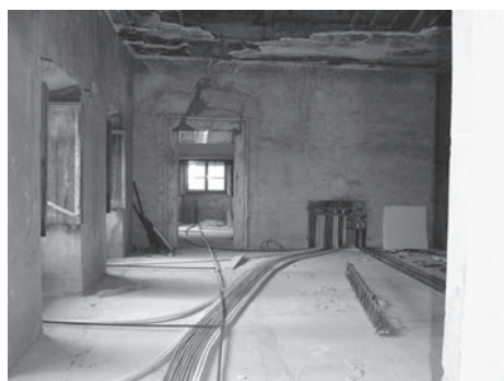
Fig. 3. Palazzo Chigi-Zondadari a S. Quirico d'Orcia (Siena), 2004-05. Vista del cantiere al momento del primo sopralluogo con alcune opere edili e impiantistiche già realizzate.
