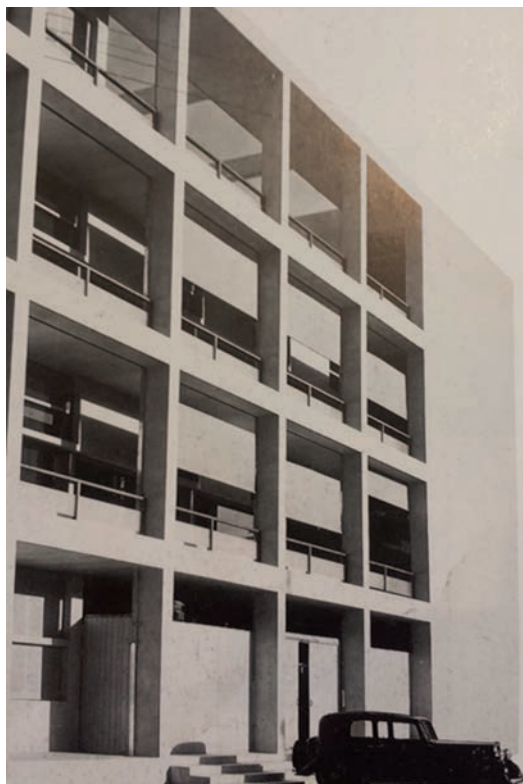
Fig. 9. Casa del Fascio a Como (arch. Giuseppe Terragni). Dettaglio del prospetto su piazza del Popolo provvisto del sistema a rullo originario che permetteva la movimentazione delle tende che scorrevano senza occupare l'intero spazio del vano murario (da EISENMAN 2004).
