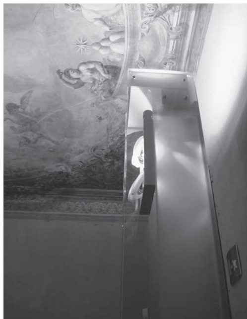
Fig. 4. Palazzo Chigi-Zondadari a S. Quirico d'Orcia (Siena), 2004-2005. Il totem tecnologico condensa le necessità impiantistiche nell'oggetto di design .
