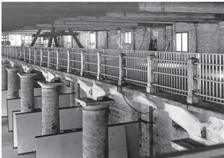
Fig. 7. Corderie. Le nuove balauste a norma aggiunte a quelle esistenti (su concessione del Ministero dei Beni e delle attività culturali – SABAP- VE-LAG, n. 50104/1987).
