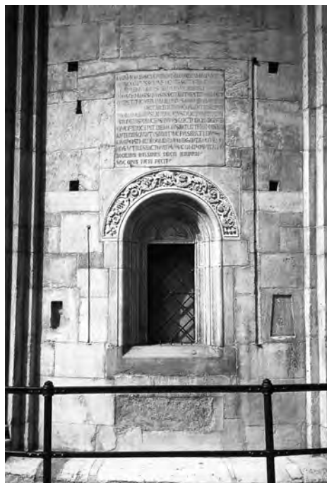
Fig. 3. Modena: modelli del mattone, del coppo e di due misure lineari scolpiti nel paramento murario esterno della Cattedrale.
