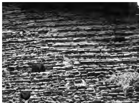
Figg. 4-5. Veduta della parete superiore della testata del transetto, lasciata al rustico; particolare del muro di tegolozze nella parete superiore della testata del transetto (foto E. Giorgi).
