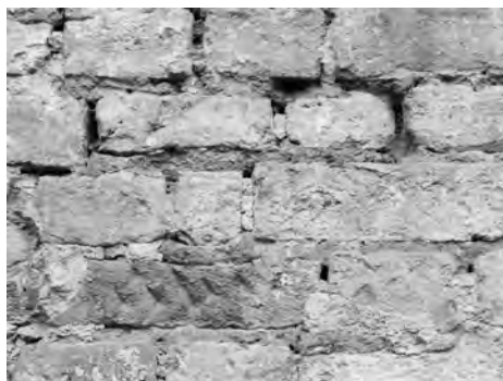
Fig. 12. Dettaglio della facciata principale di palazzo Magio Grasselli: i laterizi sono posati su malte di allettamento a base di argilla e calce.
