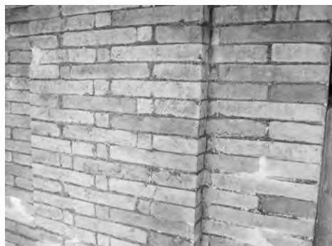
Fig. 11. Villa Farnesina alla Lungara, particolare del fusto di una parasta in facciata. Nell'apparecchiatura laterizia sono inserite fette di mattoni.
