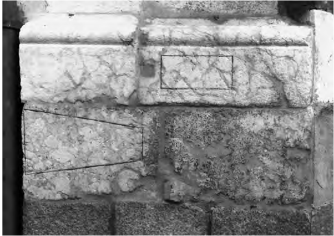
Fig. 4. Sagome dei laterizi in uso a Cremona, secondo quanto stabilito dagli Statuti cittadini. Le lastre lapidee sono situate alla base dello spigolo sud-orientale del battistero.
