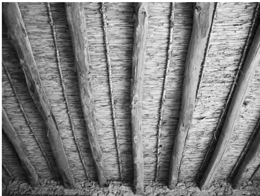
Fig. 5. Copertura costituita da travi di legno non squadrate e struttura secondaria incannicciata.
