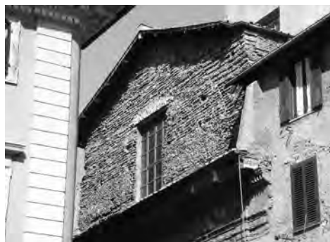
Figg. 4-5. Veduta della parete superiore della testata del transetto, lasciata al rustico; particolare del muro di tegolozze nella parete superiore della testata del transetto (foto E. Giorgi).
