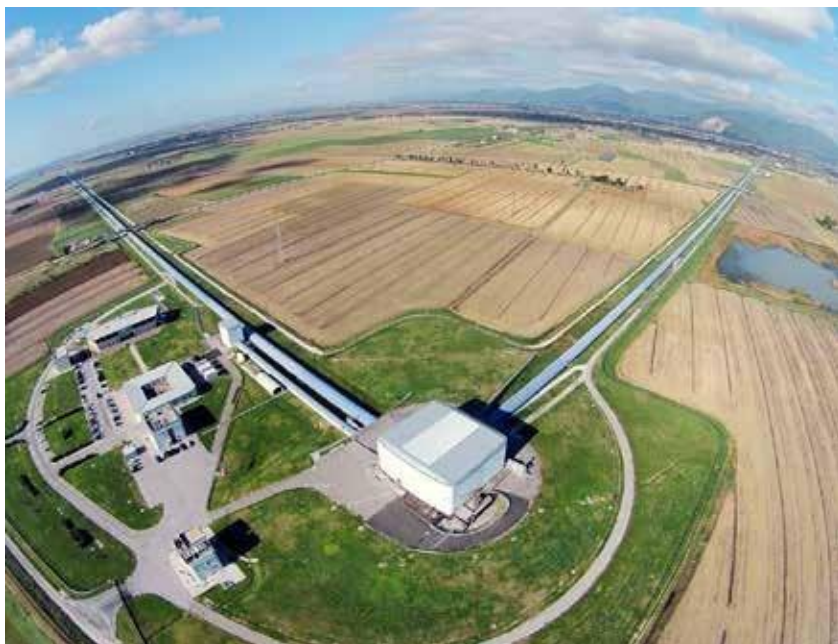
Veduta aerea dell'interferometro Virgo
