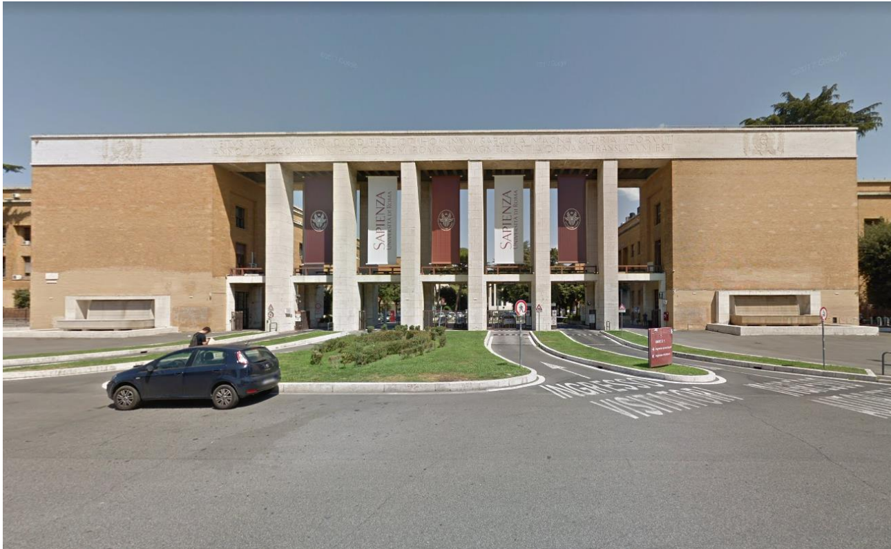
Fig. 2 – Fotografia dello stato attuale del manufatto.
