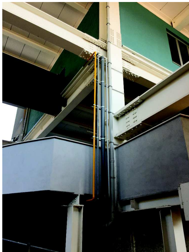
Tubazione del gas da collegare a quella principale e arrivo all'esterno del locale
