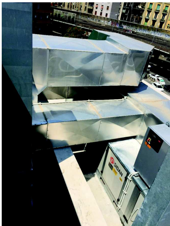
Predisposizione delle canalizzazioni di mandata, ripresa e estrazione – uta e canali in facciata
