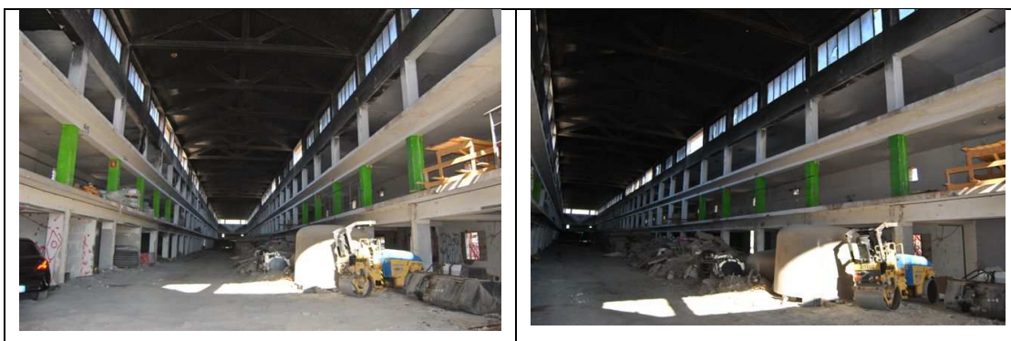
Figura 4 : Fabbricato C10, rilievo fotografico
