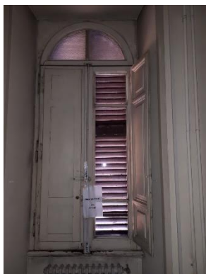
Finestra lato interno
