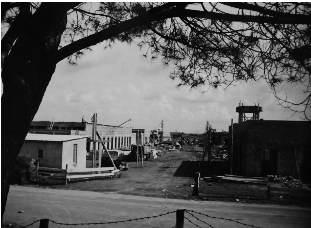
15/ Il Villaggio operaio in costruzione (foto d'epoca - ACS fondo Minnucci).
