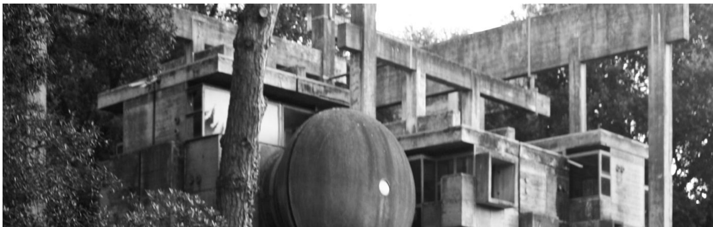
Figura 3. Giuseppe Perugini. Villa a Fregene. Parte della costruzione, datata alla fine degli anni sessanta, è appesa al telaio in cemento armato che organizza anche formalmente la composizione dei volumi. L'edificio ha provocato reazioni contrastanti sul piano del consenso. Lo stato di semi abbandono ha conferito alla costruzione un'aura di rudere moderno ben interpretata dall'obiettivo di Karl Lagerfeld che ha dedicato a quest'opera una pubblicazione in due volumi: il primo è dedicato alla casa di Fregene intitolata House on the Tree, il secondo volume ritrae la Casa Malaparte a Capri di Adalberto Libera (vedi bibl.)
