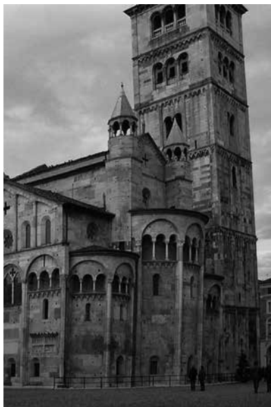
5. Duomo di Modena, particolare dell'abside.
