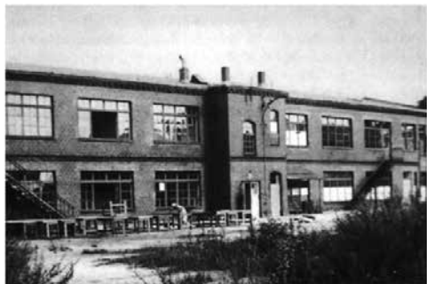
7. Edificio del Bauhaus, Berlino, 1932.
