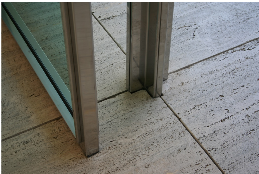
Fig. 5 – Particolare dei pilastri e dei serramenti cromati nel Padiglione di Barcellona di Mies van der Rohe, 1929
