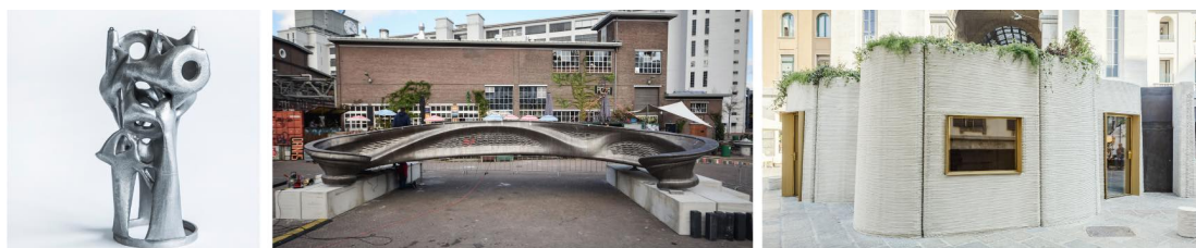
Figura 2: Stampa 3D per la struttura - lo Smart Node in acciaio (©Arup), il MX3D Bridge (©MX3D), 3Dhousing05 CSL Architetti (©CSL Architetti)
