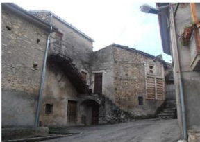
Ricostituzione di "pesale" in cemento armato e ringhiera metallica
