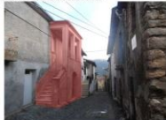
Ricostituzione di "vignale" in cemento armato e ringhiera metallica
