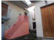
Ricostituzione di "pesale" in cemento armato e ringhiera metallica
