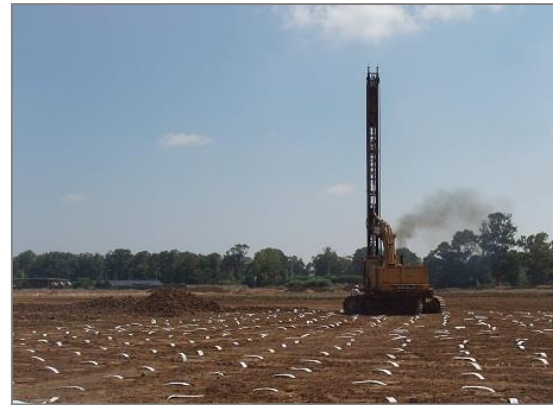
Precarica e dreni verticali prefabbricati
