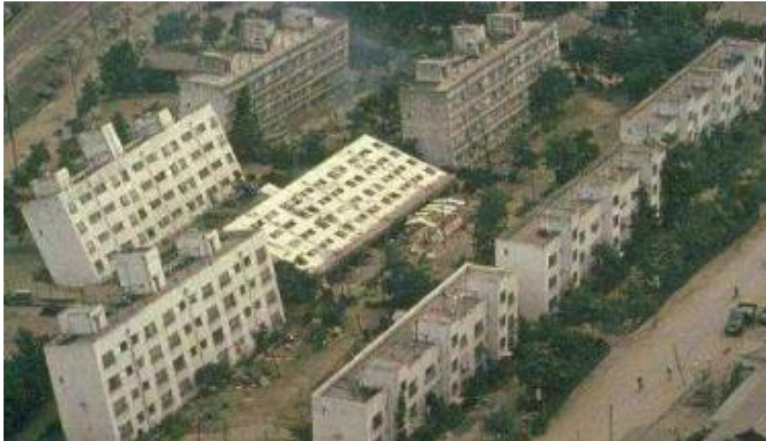
Fenomeni di instabilità indotti da liquefazione: terremoto di Niigata, 1964
