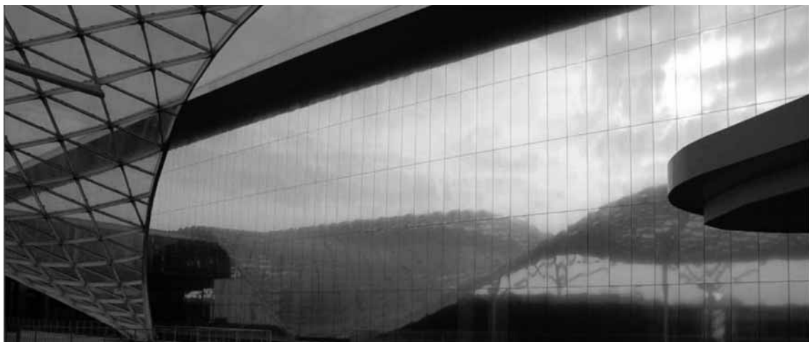
Appalto Integrato. Cantiere del Maxxi, Roma. Comune di Roma-Zaha Hadid-Cerasi/Navarra (Italiana Costruzioni spa) Adjudication intégrée. Chantier du Maxxi, Rome. Ville de Rome-Zaha Hadid-Cerasi/Navarra (Italiana Costruzioni spa)
