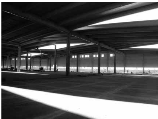
Interporto di Roma-Fiumicino: il primo capannone in fase di realizzazione visto dall'interno
