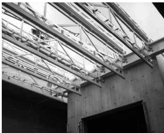
Cantiere del Maxxi, Roma. Le lamelle previste in copertura sono state oggetto di una offerta tecnica migliorativa Chantier du Maxxi, Rome. Les lamelles prévues en couverture ont été l'objet d'une offre technique améliorée
