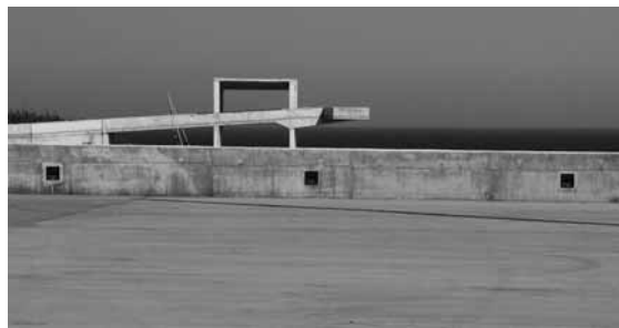
L'area del Forum 2004. Il percorso sospeso, prolungamento della Diagonal, rafforza il legame città mare Le secteur du Forum 2004. Le parcours suspendu, prolongement de la Diagonal, renforce le lien entre la ville et la mer
