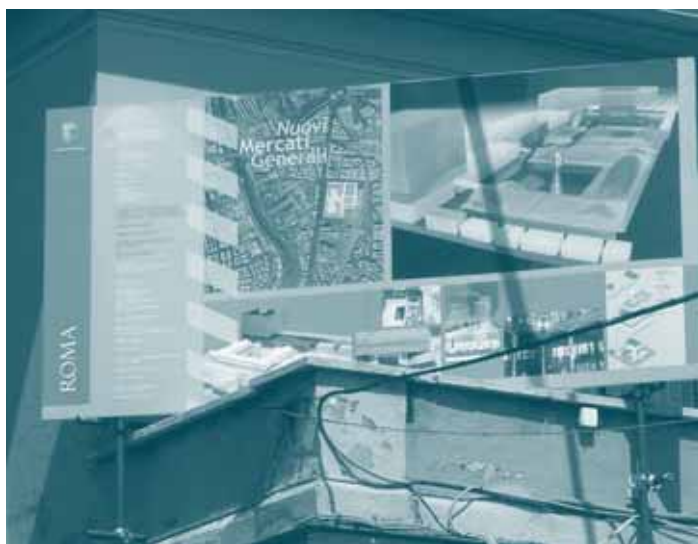
Roma, Mercati Generali: Cartellonistica, edifici preesistenti, prime attività di cantiere Rome, Halles: signalétique, bâtiments pre-existants, chantier en cours
