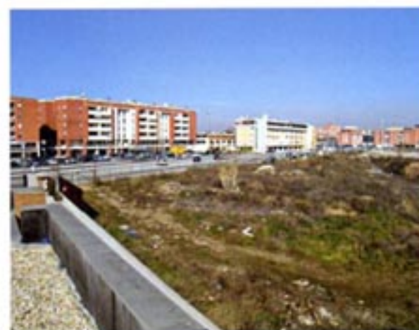
L'area di Casal Monastero si trova in un quartiere in corso di completamento nella zona nord-est di Roma e sviluppa una superficie di 11.000 mq
