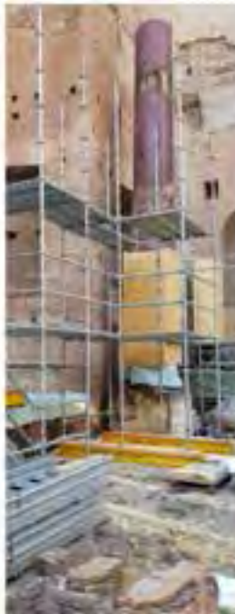
✔ Ottimizzazione delle fasi di lavoro
